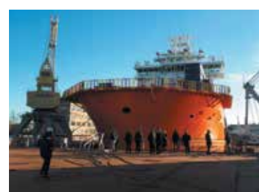
Специалисты «Акер Арктик» знакомятся с ходом строительства ледокола «Андрей Вилькицкий» на ВСЗ
